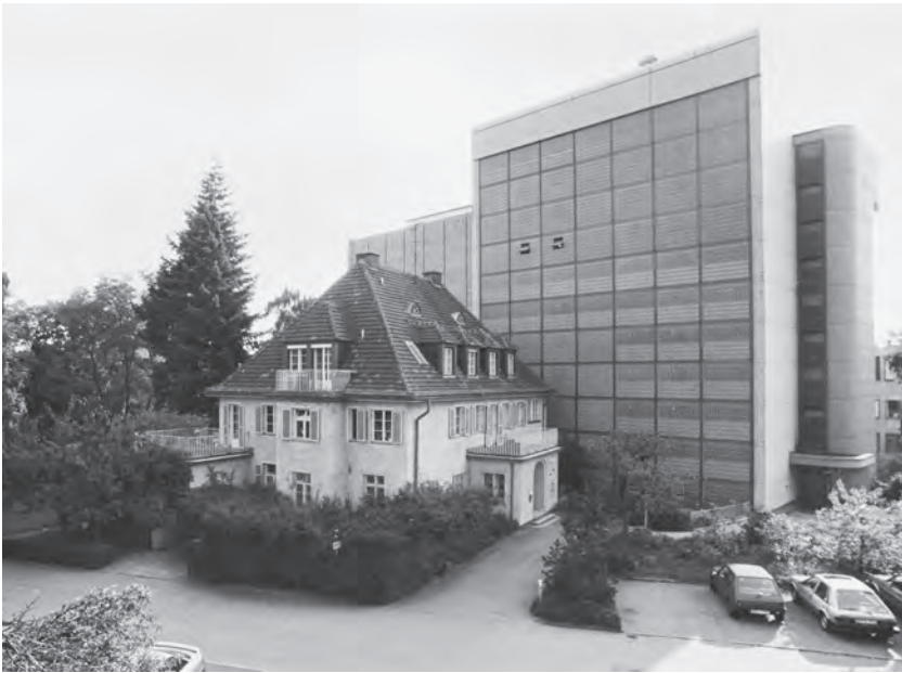
Abb. 2: Die ehemalige Direktoren-Villa des KWI-A, in der Hermann Muckermann 1949 bis 1961 sein Anthropologie-Institut leitete, ist hier in den 1990er-Jahren vollständig in die Gebäudelandschaft der Freien Universität integriert.
