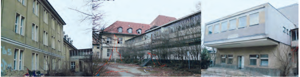
Abb. 3: Ansichten der ehemaligen FU-Frauenklinik kurz vor dem Abriss, März 2012.
